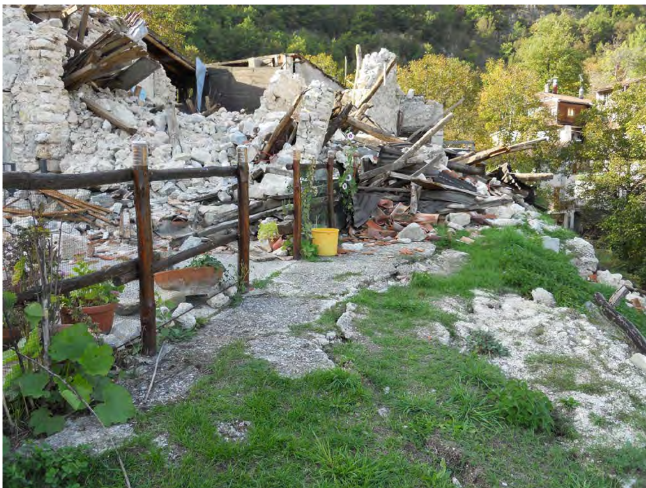
Danni prodotti dal terremoto del 29 dicembre 2020 in Croazia.
